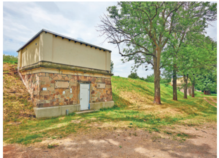
Trinkwasserbehälter wie dieser sind Bestandteil unserer Trinkwasserversorgung. Quelle: Wasserwerke Zwickau GmbH – Foto-Atelier Lorenz
