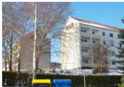
Geschosswohnungsbau der 1980er Jahre
