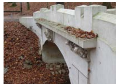
Brücke im Sahnpark
