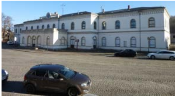
Foto: Ansicht Platzseite (Westfassade)
