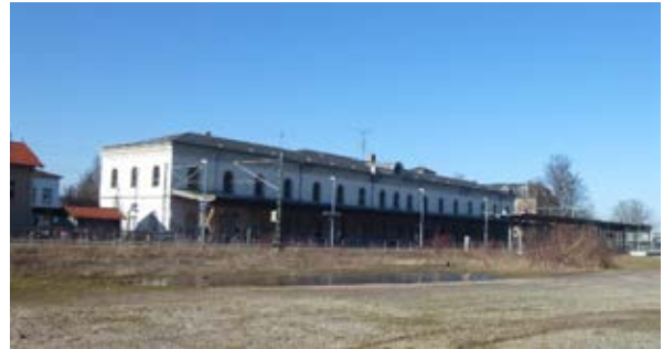
Foto: Ansicht Gleisseite
