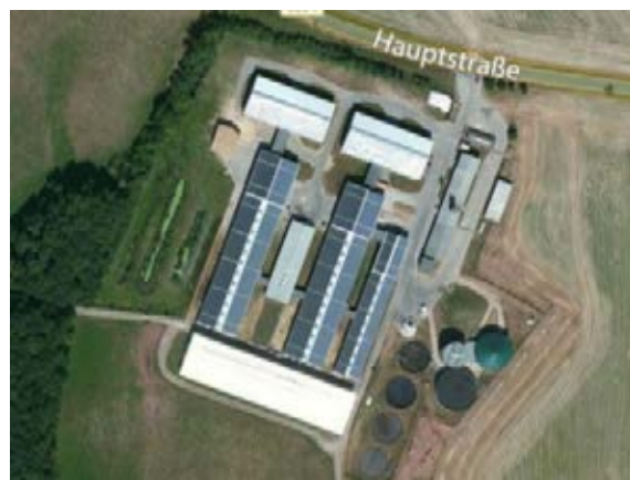
Biogas und Solaranlage Agrargenossenschaft Blankenhain, OT Langenreinsdorf
