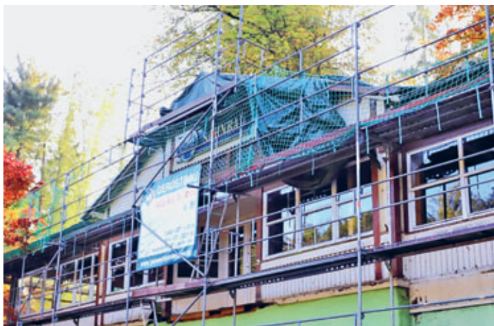
Notsicherung des Daches hat begonnen © Matthias Wienold
