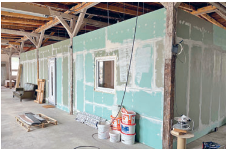
Zurkraft Studios während der Umbauphase
