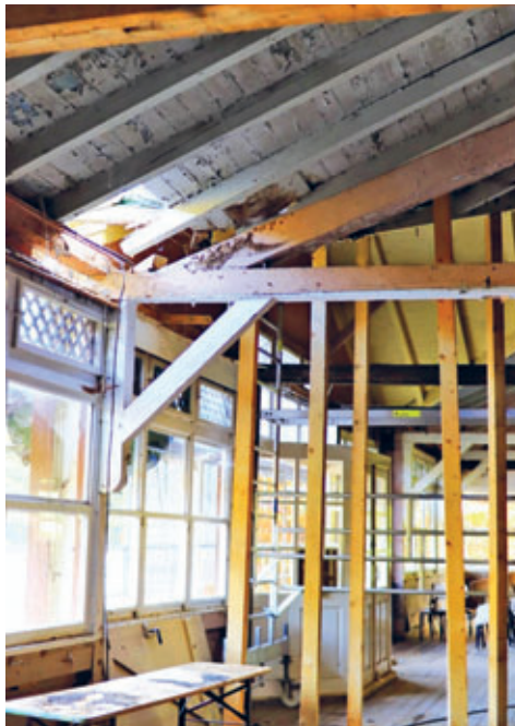
Blick in die Kantine © Matthias Wienold
