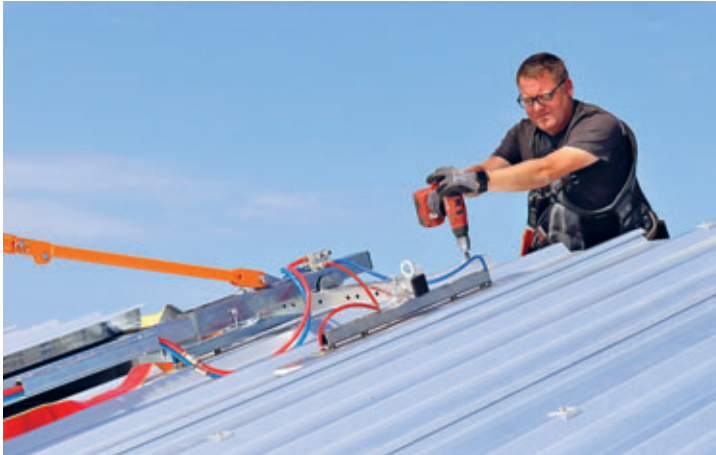
Mitarbeiter Sebastian Schär auf dem Dach des Firmengebäudes
